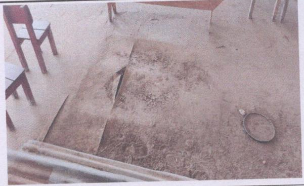
Foto 8: Sustitución de piso granito
